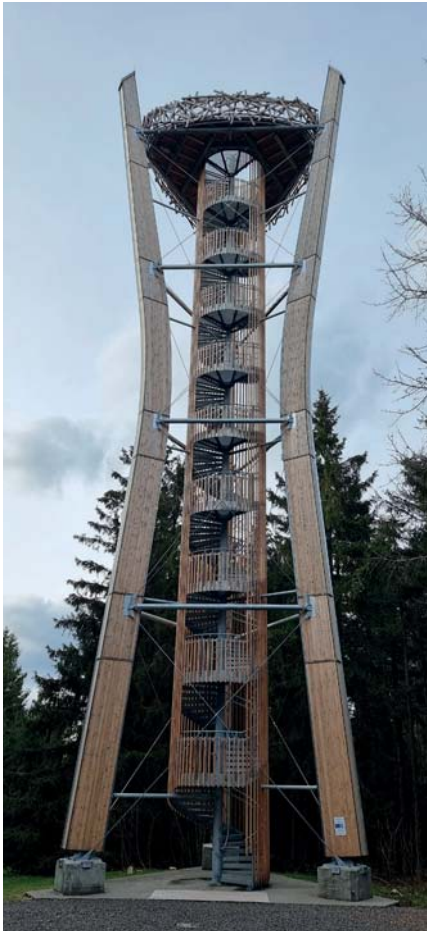
Bild 19: Auf jedem Podest der Stahlterappe ist die Staketen-Bekleidung unterbrochen und gibt den Blick in Richtung Süden frei. (Foto: Hannsjörg Pohlmeier)
