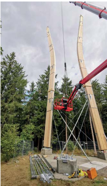
Bild 16: Temporäre Abspannungen stabilisieren die Stützen, bis die Druckriegel und die Auskrenzungen montiert sind. (Foto: Schaffitzel Holzindustrie)
