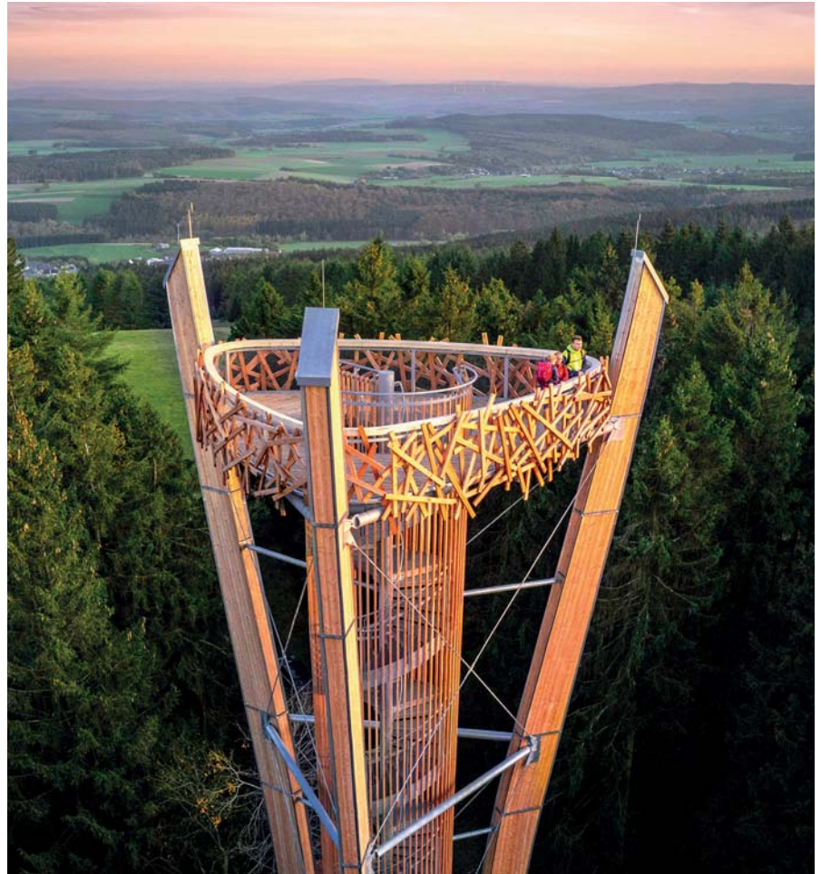
Bild 20: Weitblick über die Baumwipfel. Die Transparenz des Turmes ermöglichen mitunter die filigranen Stahl-Aussteifungsverbände in den drei Richtungsebenen zwischen den Stützen. (Foto: EdelSteinLand – Renée Nolte – soonteam cc)
