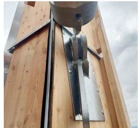
Bild 6: Links: Isometrie Knotenanschluss an BSH-Stütze mit Rundum-Bekleidung (ohne Darstellung des zweiten Blechs auf der Bekleidung, wie im Foto rechts zu sehen) (Zeichnung: Ingenieurbüro Miebach) Rechts: Die horizontalen Druckriegel konnten über Blechfahnen und Passbolzenverbindungen einfach und schnell angeschlossen werden. Das zweite Anschlussblech ist auf der Bekleidung aufgebracht. (Foto: Schaffitzel Holzindustrie)
