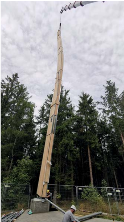
Bild 15: Die Stützen werden am Stück mit dem Kran eingehoben. (Foto: Schaffitzel Holzindustrie)
