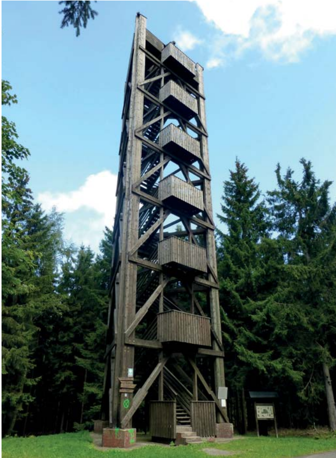
Bild 2: Der alte, 24 m hohe Aussichtsturm musste abgerissen werden. Ein Brand hatte ihn stark beschädigt. (Foto: wikimedia commons)
