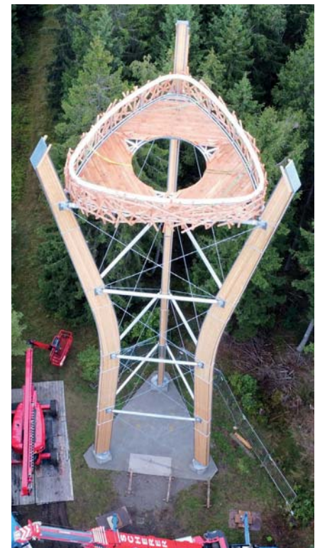
Bild 18: ... und auf der obersten Druckriegel-ebene montiert. (Foto: Schaffitzel Holzindustrie)
