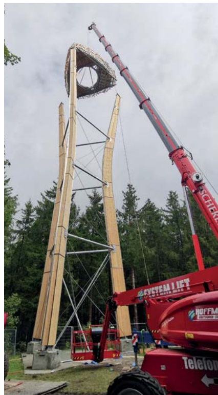
Bild 17: Die Aussichtsplattform wird per Kran von oben abgelassen ... (Foto: Schaffitzel Holzindustrie)
