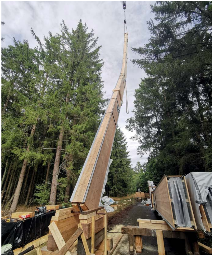
Bild 13: Die rund 31 m langen Stützen wurden als Ganzes vorgefertigt – inklusive des „bauteilbezogenen Holzschutzes“ in Form einer Rundum-Bekleidung – und dann auch am Stück eingehoben und montiert. (Foto: Schaffitzel Holzindustrie)
