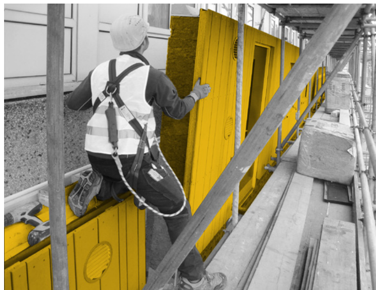
Abb. 72: Elementstoß mit Mineralwolle zur Schallentkoppelung
