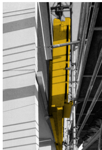
Abb. 79: Ablassen des Elements zwischen Bestand und Gerüst
