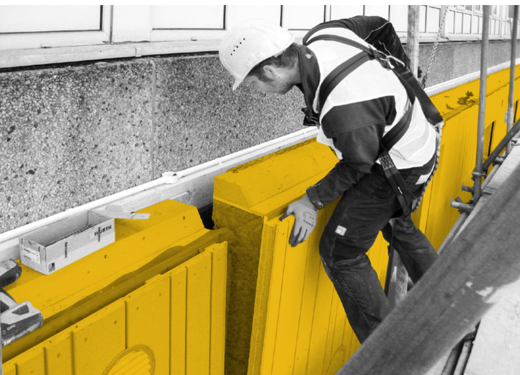
Abb. 42: Montage Fassade, horizontaler Stoß
