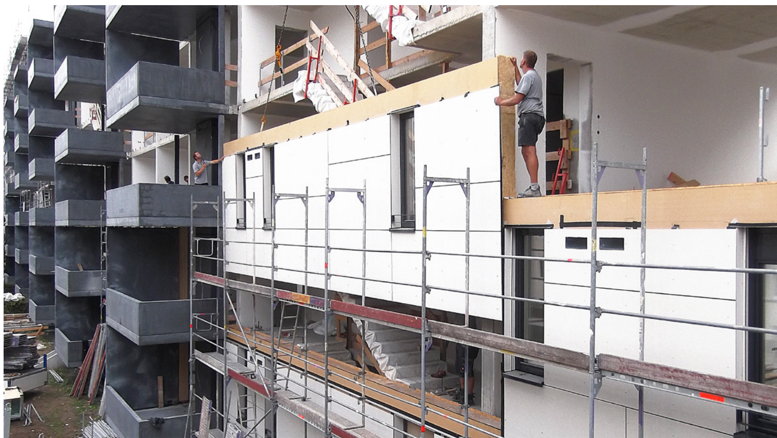
Abb. 3: Montage eines vorgefertigten Fassadenelementes
