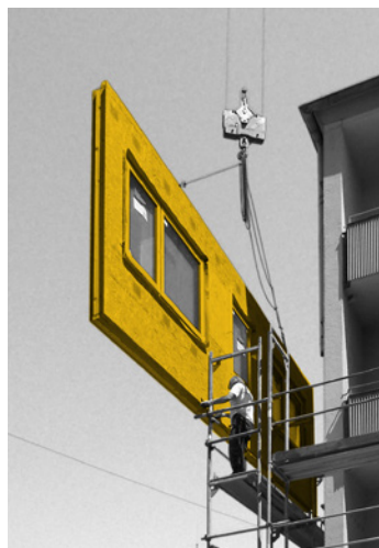
Abb. 78: Einfädeln des Fassadenelements zwischen Bestand und Gerüst
